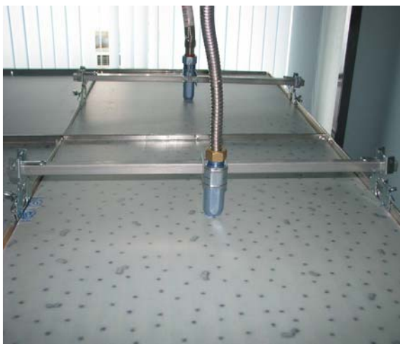
3. Реечное крепление со специальным фитингом для жесткой фиксации подводки на направляющих подвесного потолка, а также в потолке зашитом гипсокартонном. Данная система позволяет регулировать положение спринклера по высоте, а также позволяет осуществлять обслуживание (монтаж/демонтаж спринклера без вскрытия потолка) (Рекомендовано при длине подводки более 80см).
