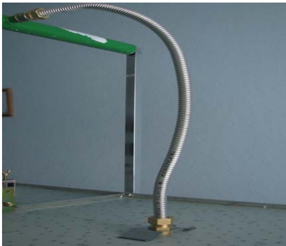
1. Зажим для крепления гибкой подводки (фитинга) в панели подвесного потолка. (Рекомендовано при длине подводки более 40см)
