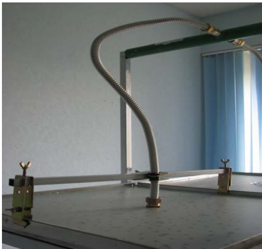
2. Реечное крепление для жесткой фиксации подводки на направляющих подвесного потолка. Данная система позволяет регулировать положение спринклера по высоте. (Рекомендовано при длине подводки более 80см).
